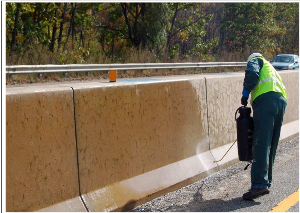
Abb. 2.20 Oberflächliche Applikation von Lithiumnitrat [Folliard 2008].
