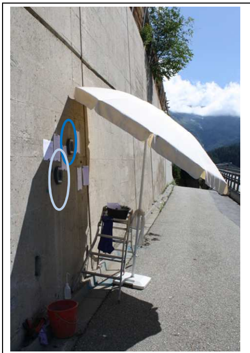
Abb. 3.8 S0751; Messung der Wasseraufnahme am Objekt mit der 2-Kammer-Messzelle (blau) und mit Karstenröhrchen (hellblau). Messfläche beschattet.
